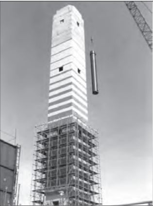
高さ59mの煙突。景観に合わせた緑色に塗装。
