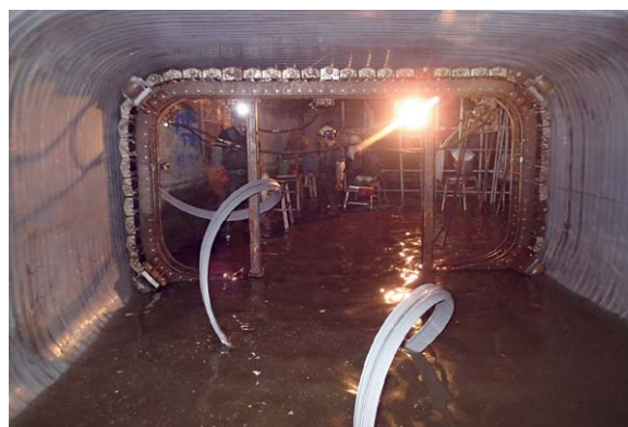
下水道管再生工事
