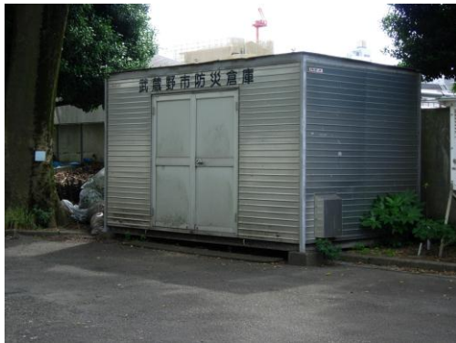
【図表 11-10 避難所防災倉庫】
