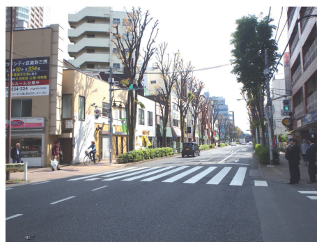
特定緊急輸送道路である三鷹通り
