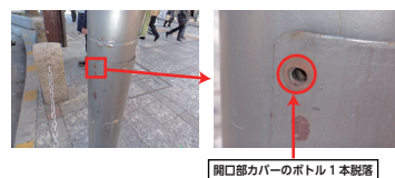
開口部カバーのボルト 1 本脱落
