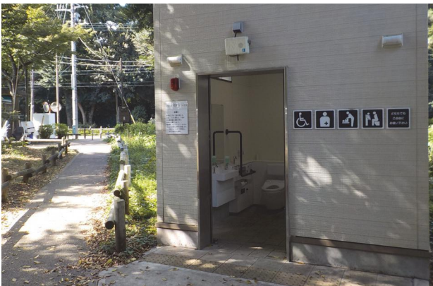
トイレの改修（都立井の頭恩賜公園）
