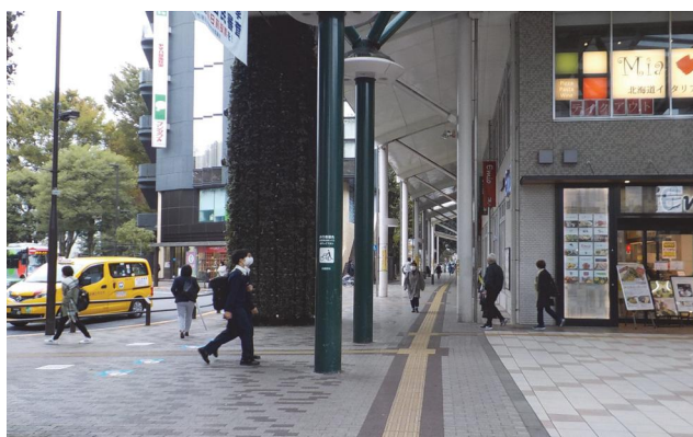
バリアフリー化された道路
