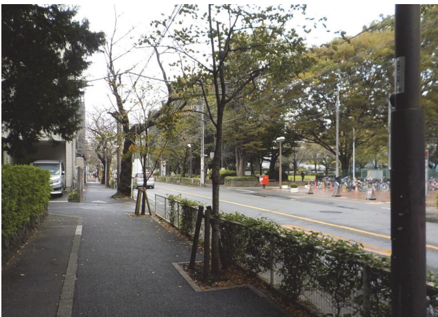
街路樹の根上がり解消（中央通り）
