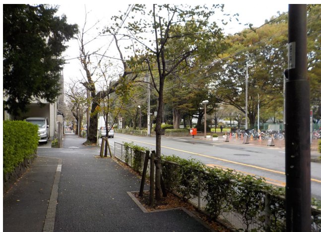
街路樹の根上がり解消（中央通り）
