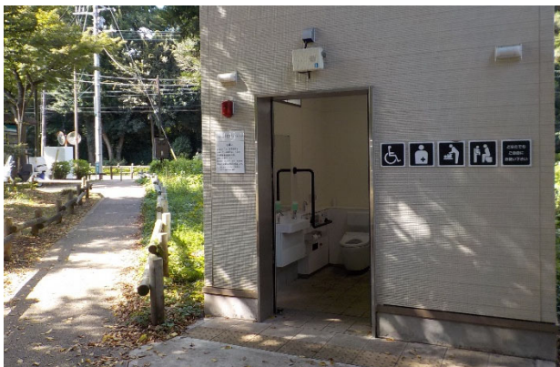
トイレの改修（都立井の頭恩賜公園）
