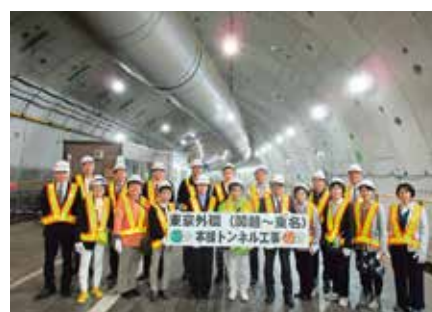
東京外かく環状道路 東名側本線トンネル工事現場
