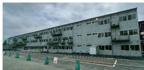
校庭側から見た仮設校舎
