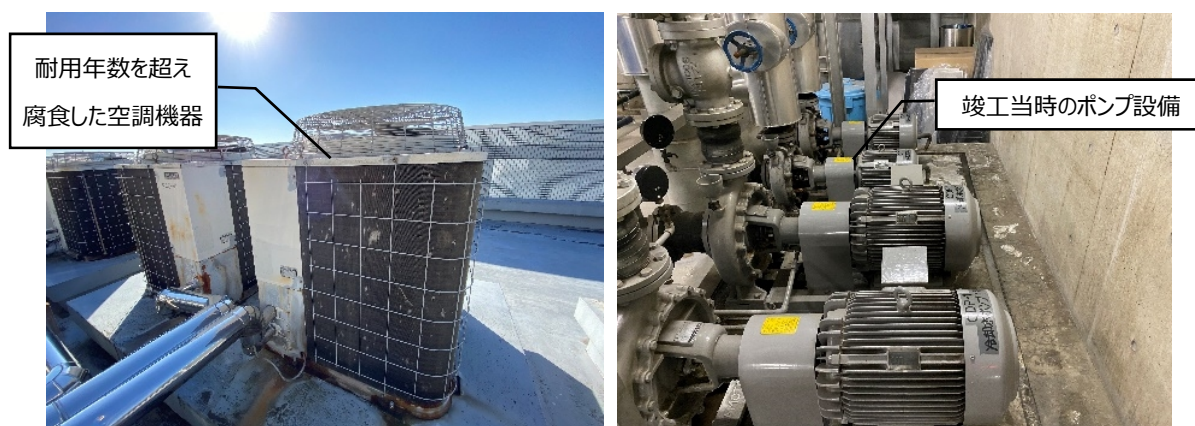
腐食や老朽化が進む空調設備の状況
