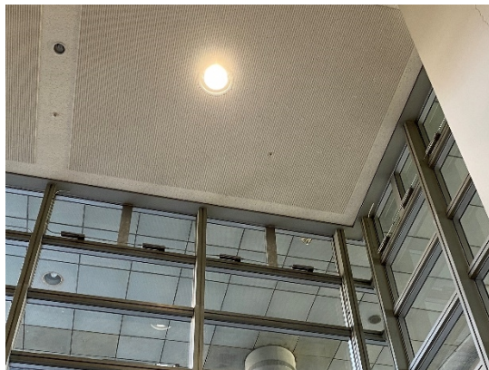
○窓の開閉装置が劣化し開閉し難い高窓（各階一部）
