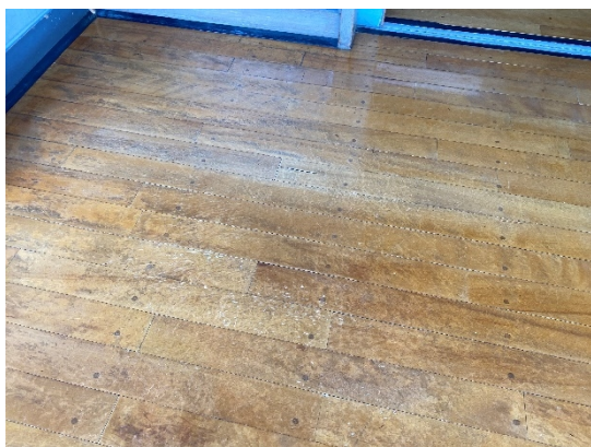
○劣化している廊下や弓道場の競技用フローリング（４階）
