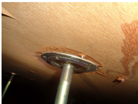
○金物の剥離が見られる競技用フローリングの床下地（1階）
