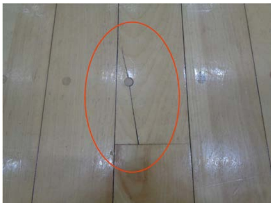
○劣化しているメインアリーナの競技用フローリング（割れの発生）（1階）
