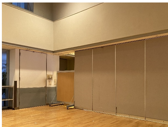
○劣化し使用できないパネルがある移動間仕切り壁（１階）
