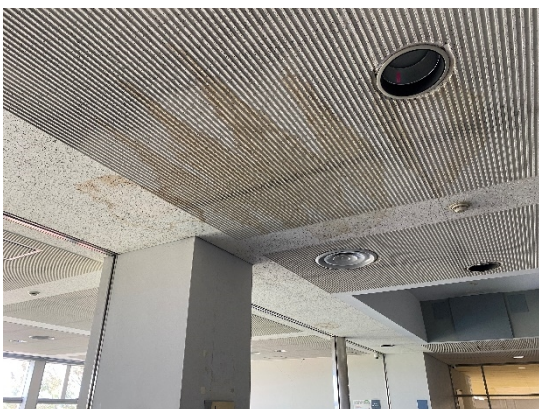
○漏水等による天井のシミ（各階一部）
