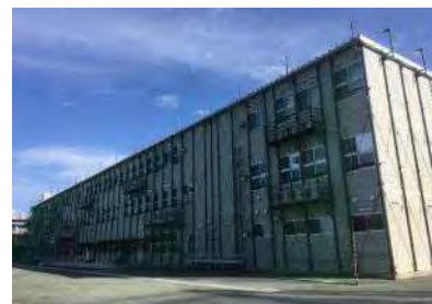
校庭側から見た仮設校舎
