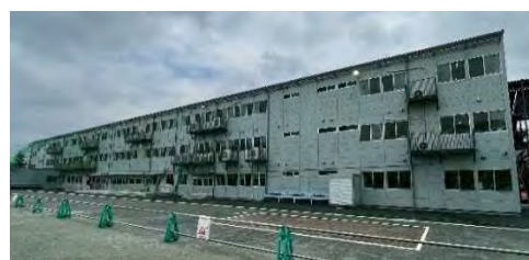
校庭側から見た仮設校舎
