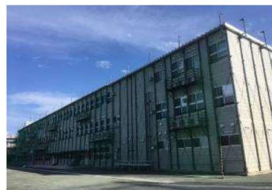
校庭側から見た仮設校舎
