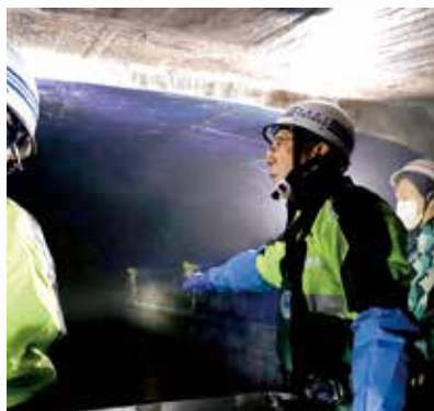
下水道管内部の視察の様子
