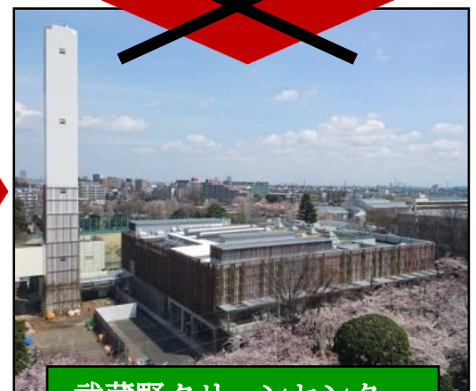
武蔵野クリーンセンター
