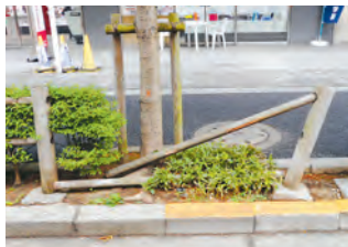
▲防護柵の破損
