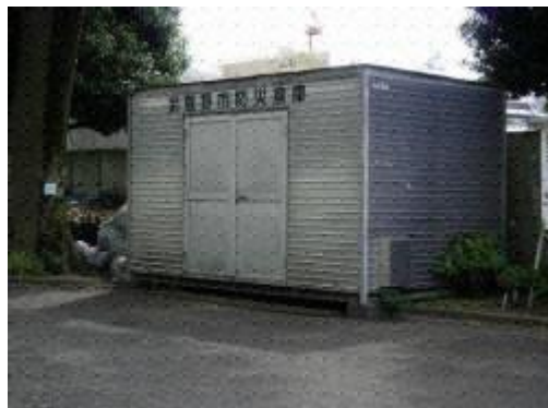
図表 3-9-9 避難所防災倉庫
