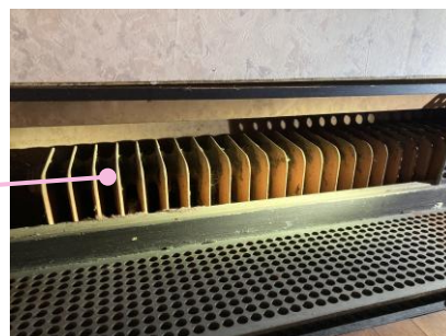
ラジエーターグリル内部
