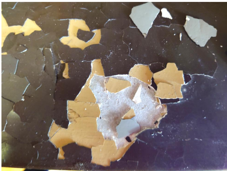
暖炉上部コンクリート棚（塗装剥がし試験より判明した旧来の塗装）
