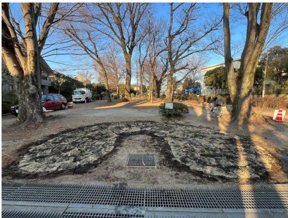
(完成した雨庭 B)
