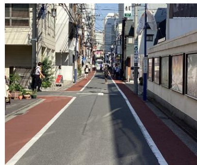
路側帯(カラー舗装)
