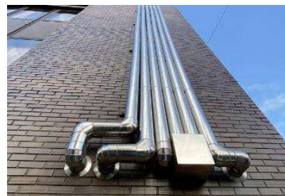
▲屋外露出 給排水配管外観①
