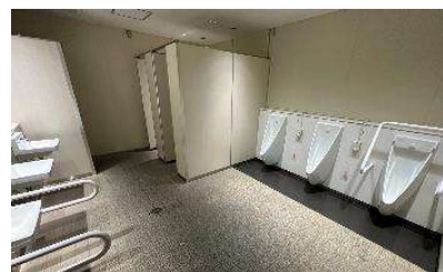
▲施設内 トイレ増設(2～3階のみ)
