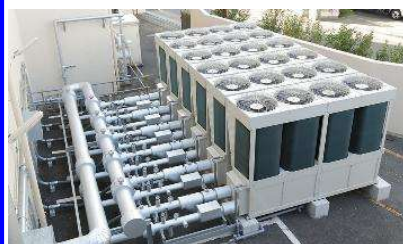
▲屋外設置 空調機器(空調機、熱源機)
