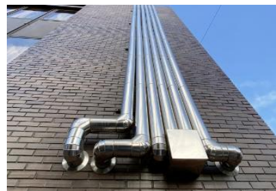
▲屋外露出 給排水配管外観①
