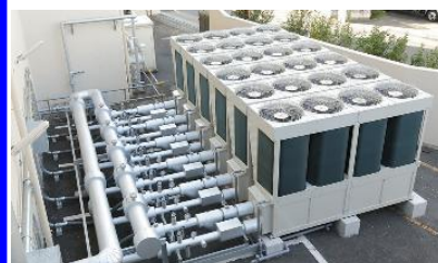
▲屋外設置 空調機器(空調機、熱源機)
