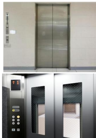
▲施設内 エレベーター増設
